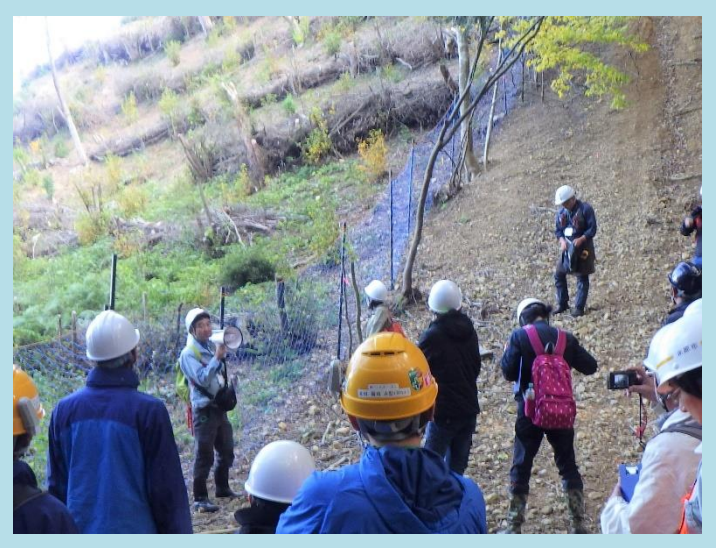
柵の点検実習
