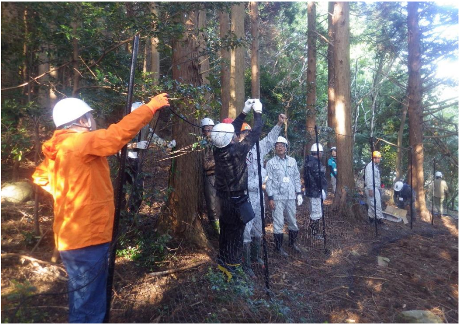
植生防護柵の設置実習
